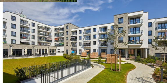
Bildquelle: Adlershorst Baugenossenschaft eG, Paloh Architekten
